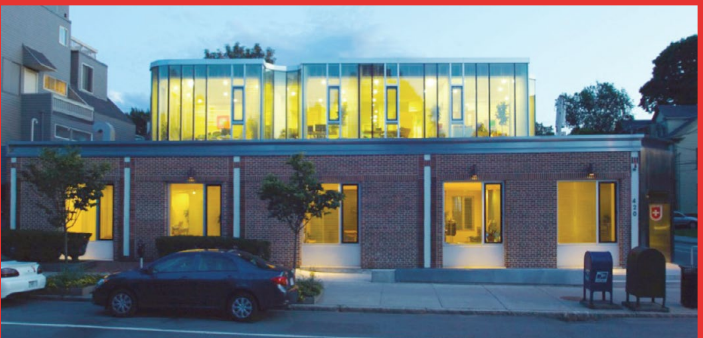
Das Gebäude des ersten swissnex-Standorts in Boston. Oben vor dem Umbau, unten nachher. Bilder: zVg
