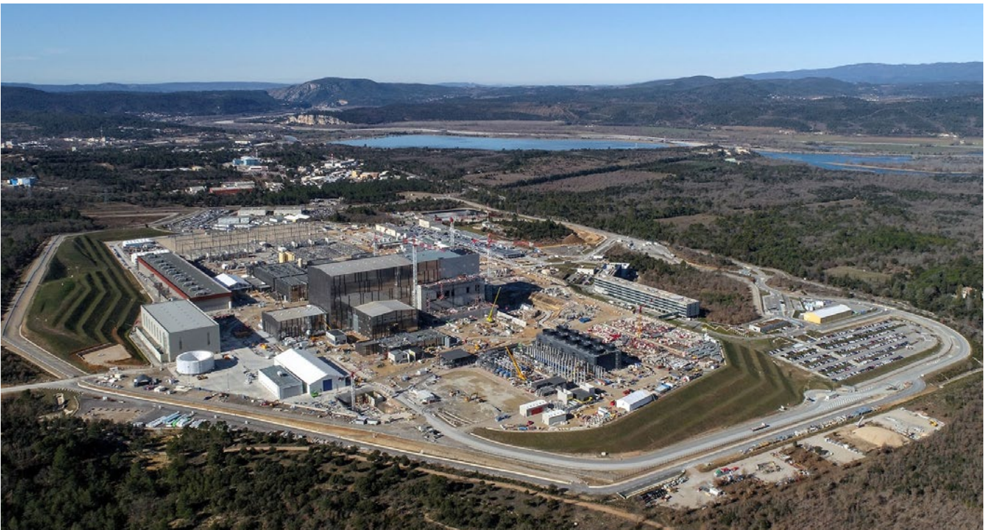
Luftaufnahme der ITER-Baustelle im Februar 2020 mit der Montagehalle und dem Tokamak-Komplex. Foto: ITER Organization/EJF Riche
